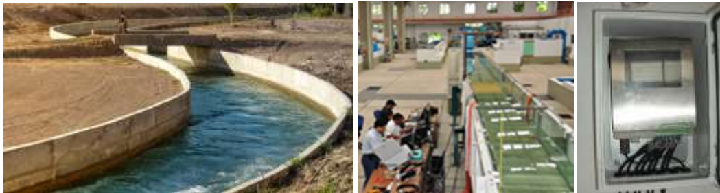
Figura: Canal de Riego / Pruebas / Medidor.
